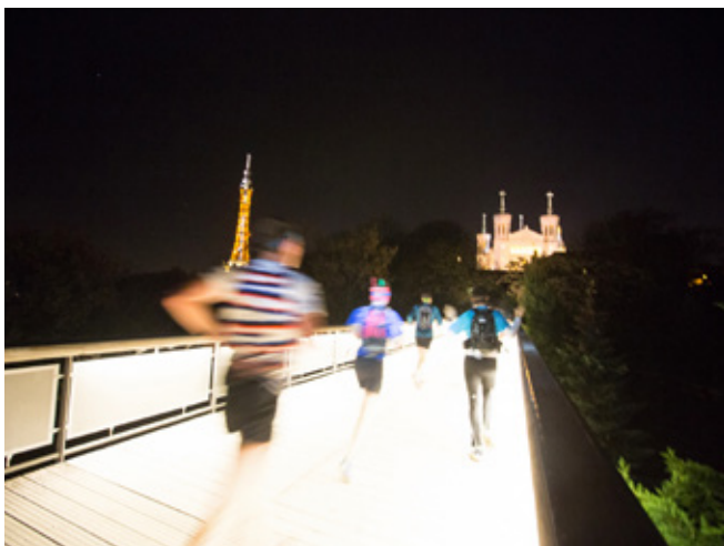
13 • La Passerelle des quatre vents.
